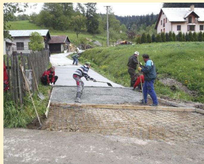
Betónovanie miestnej komunikácie na Poľunke
