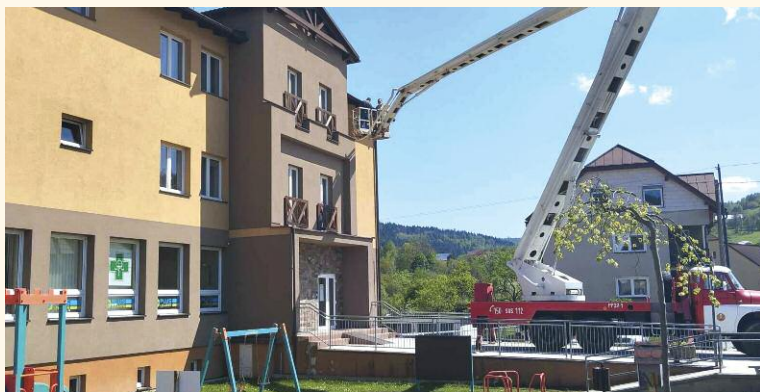
Drobné rekonštrukcie nájomných bytových domov
