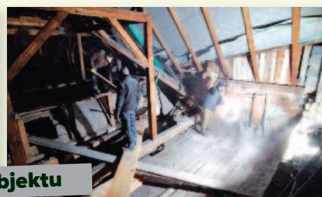
Oprava viaduktu do Vempl'a
