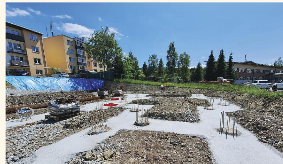
Zahájenie prác na výstavbe bytového domu 19 b.j. Skalité Kudlov
