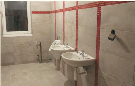
Prebieha rekonštrukcia sociálnych zariadení v hasičskej zbrojnici
