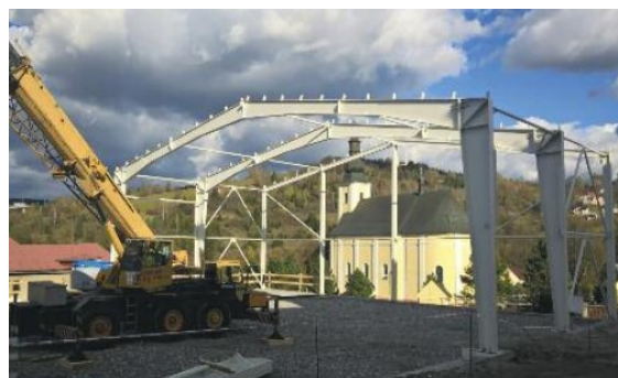
začiatok výstavby športovej haly v centre obce
