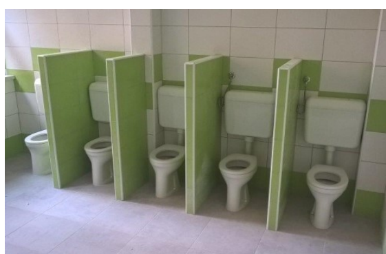
rekonštrukcia sociálnych zariadení v MŠ Ústredie
