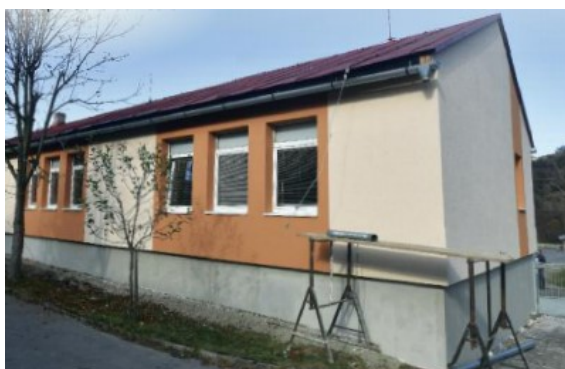
obnova fasády CVČ
