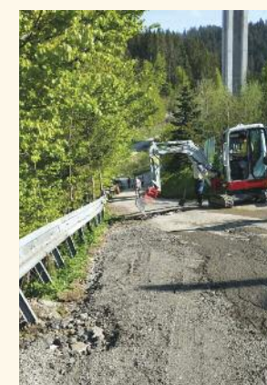
Asfaltovaniu predchádzala – lámanie betónu, vyrovňovanie, navážanie a odvodňovanie MK U Čaňa
