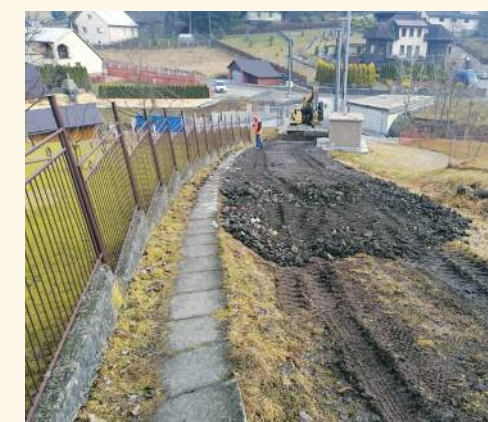
Asfaltovaniu predchádzala – lámanie betónu, vyrovňovanie, navážanie a odvodňovanie MK U Čaňa
