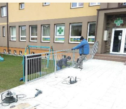
Oprava vstupu do Zdravotného strediska
