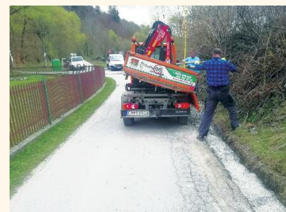
Asfaltovaniu predchádzala – lámanie betónu, vyrovňovanie, navážanie a odvodňovanie MK U Čaňa
