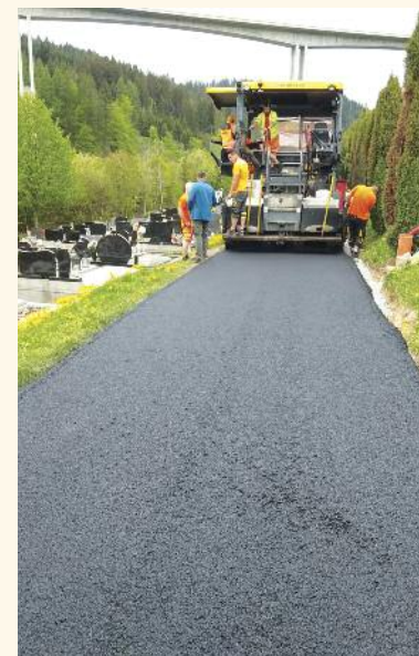
Asfaltovanie na cintoríne
