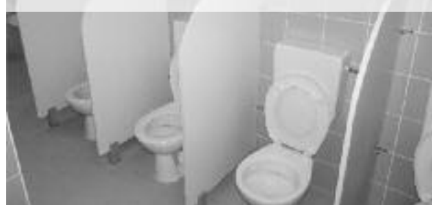
V materskej škôlke Skalitz-Kudlov sa cez letné prázdniny zrealizovali práce na sociálnych zariadeniach. Vznikli 3 samostatné miestnosti s WC misami a umývadlami pre 3 triedy, ale i samostatné Wc pre personál a šatňa.
