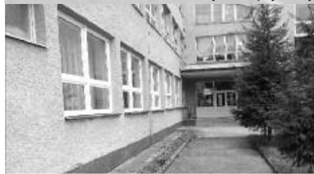
Cez letné prázdniny sa vymenili okná a vchodové dvere zo severnej časti prízemí materskej školy v Ústredí. Finančné prostriedky boli použité z účelovej dotácie Úradu vlády.
