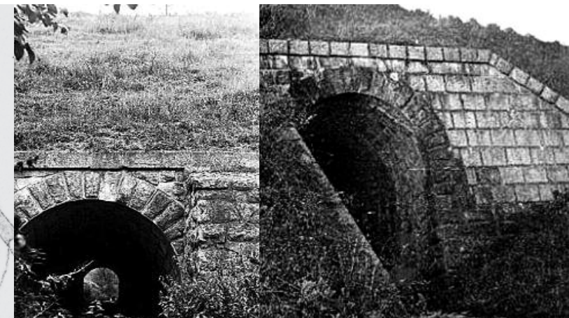
Ukážky kamenárskej práce na viaduktoch
