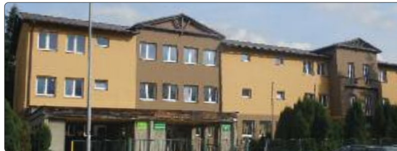
Prestavba zdravotného strediska - vzniklo 16 nových nájomných bytov
