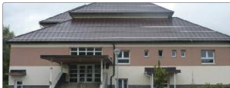
Rekonštrukcia Cirkevnej školy
