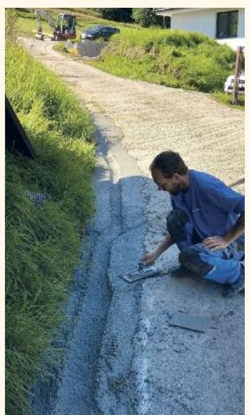
Odvodnenie miestnej komunikácie u Mikulov
