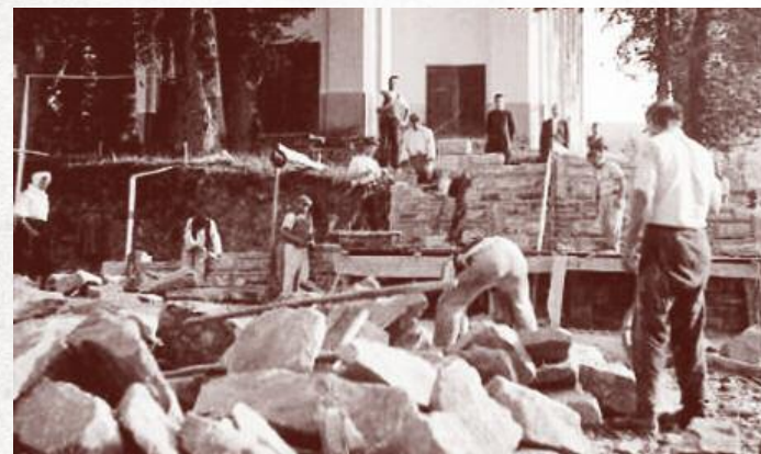
Stavba oporného múru a západného schodiska 1940. Hore zľava: murársky majster Ondrej Časnocha Čaky, farár Peter Černo a Jozef Časnocha Mikš.
