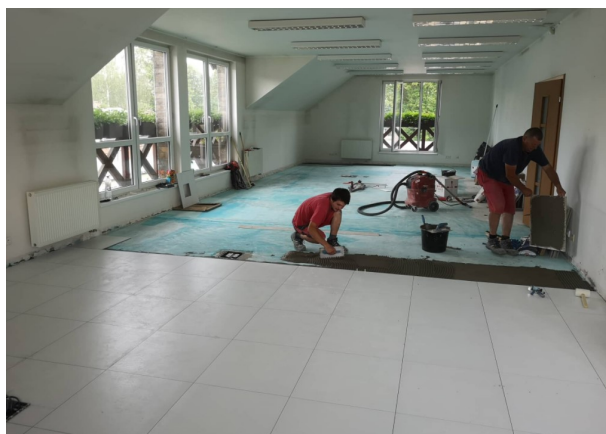
Oprava podlahy Obecného úradu
