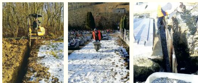
Odstránenie havarijnej situácií v sektore „E“ cintorína Skalité Rieky odvodnením podmáčaných častí.
