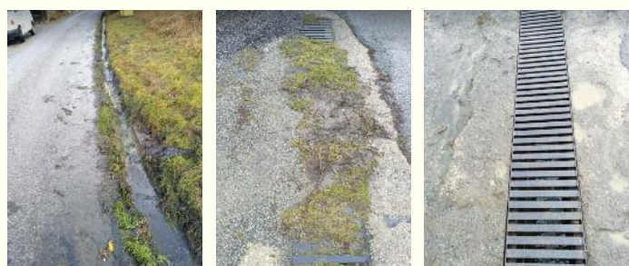
Vyčistenie cestných odrazov a žľabov.
