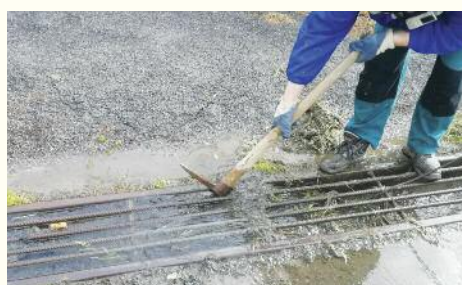
Vyčistenie cestných odrazov a žľabov.
